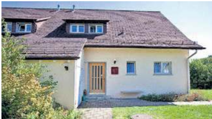
Das Gästehaus 2 wird im Oktober abgerissen – zugunsten eines Neubaus. Bild: pag
