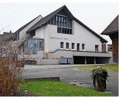
Das Restaurant Post in Adlikon bei Andelfingen steht bald ohne Pächter da – und muss dringend saniert werden. Foto: M. Schoder
